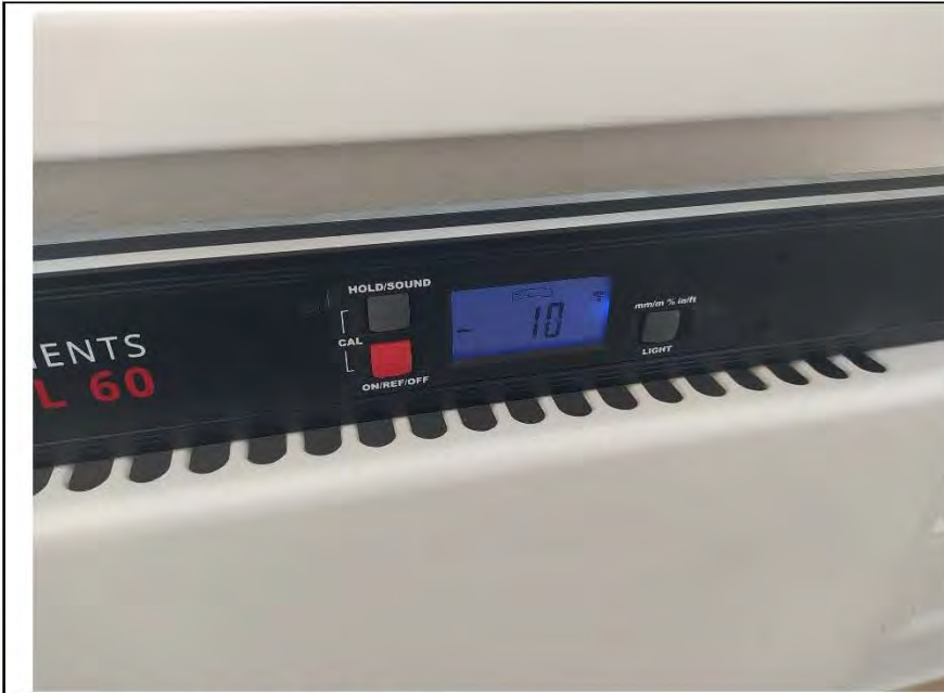
Фото №43. Отопительный прибор смонтирован неровно в гостиной.
