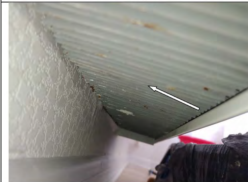
Фото №41. Радиатор в кухне имеет дефекты (коррозия)
