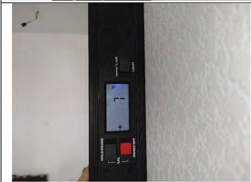
Фото №9. Измерения уровня стен в кухне.
